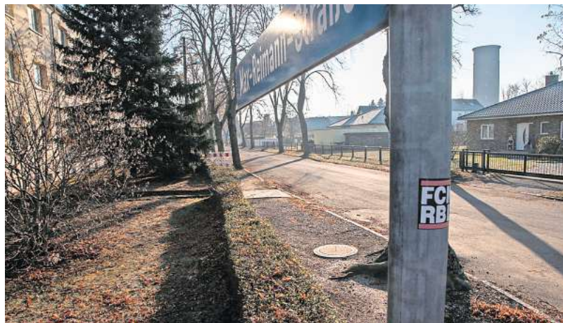
Auf dieser Seite der Max-Reimann-Straße in Deutzen stehen die Alleebäume direkt auf dem Abwasserkanal.
