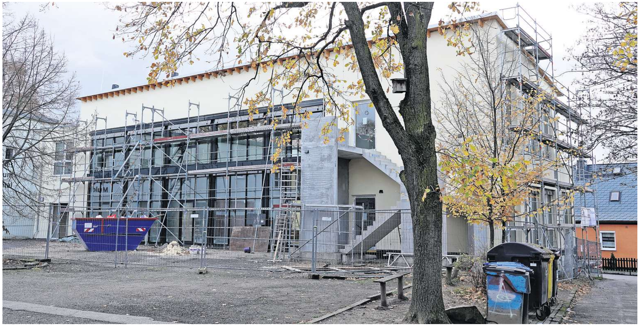
Der Anbau am Evangelischen Schulzentrum Großbardau steht kurz vor der Fertigstellung.
