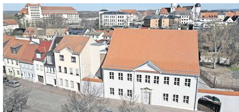
Das Geburtshaus von Joachim Ringelnatz ist nach umfangreichen Sanierungsarbeiten nun endlich fertig und wurde am 21. April offiziell dem Ringelnatzverein als Betreiber übergeben.
