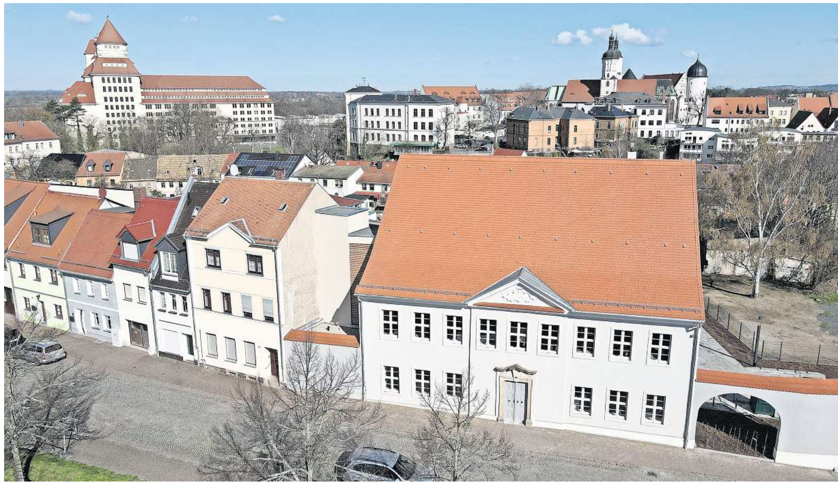
Schmuckstück im Crostigall: Das Geburtshaus von Joachim Ringelnatz ist nach umfangreichen Sanierungsarbeiten nun endlich fertig und wird am 21. April offiziell dem Ringelnatzverein als Betreiber übergeben. FOTO: FRANK SCHMIDT
