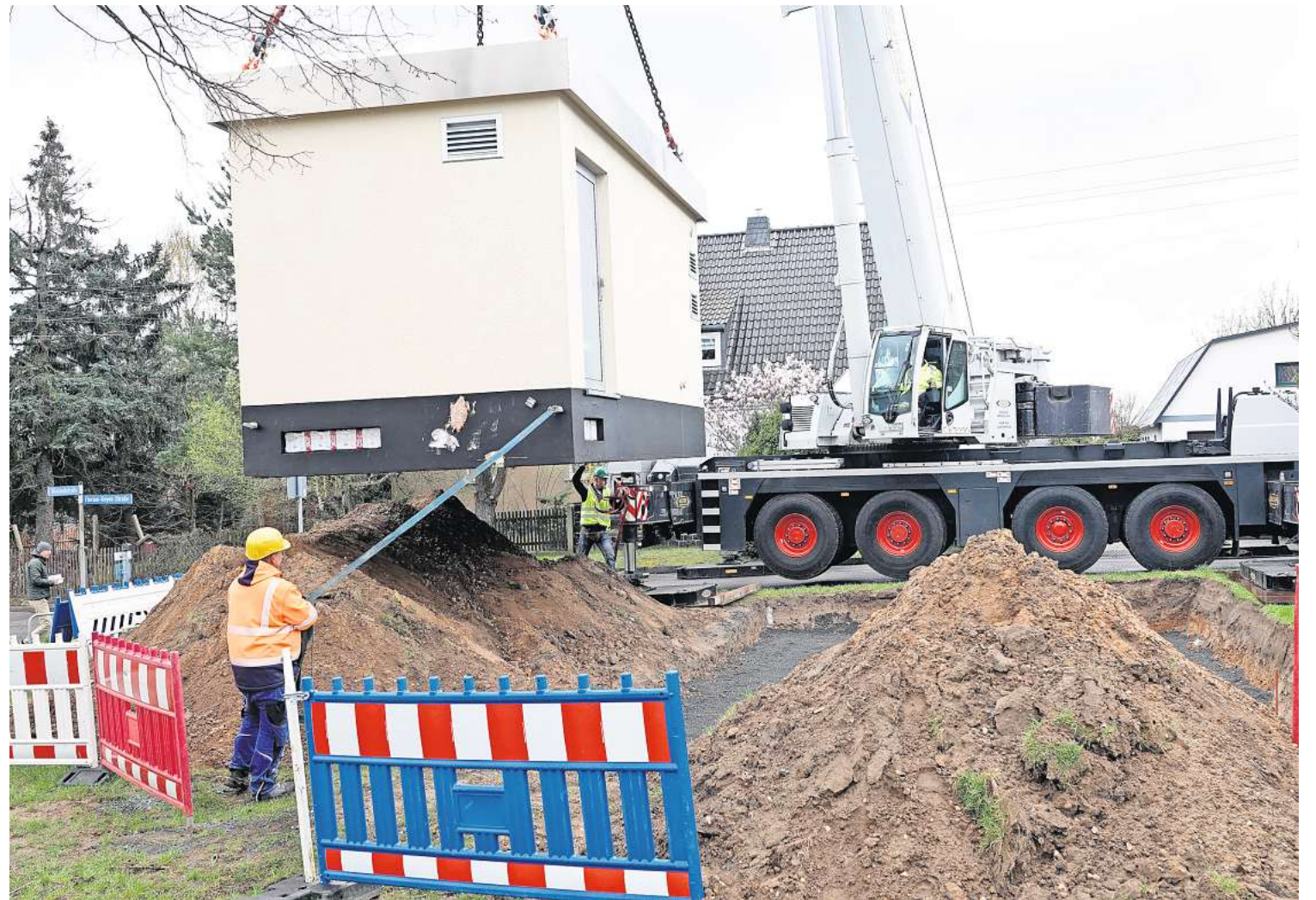
Nun hat auch Hohnstädt seinen Point of Presence. Der 34 Tonnen schwere Hauptverteiler aus Stahlbeton wird auf der Wiese millimetergenau gesetzt. FOTO: THOMAS KUBE
