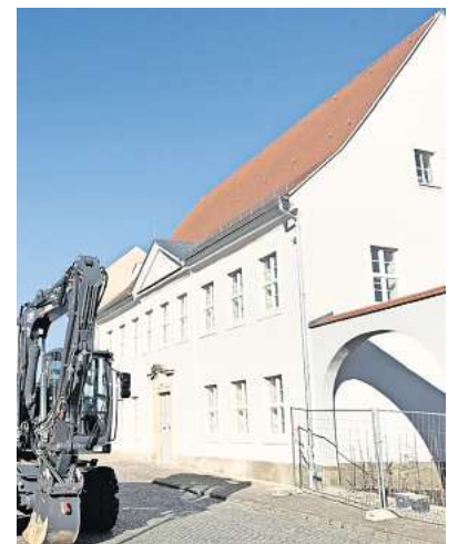
Die Arbeiten am und im Ringelnatz-Geburtshaus stehen kurz vor dem Abschluss. FOTOS: KAI-UWE BRANDT
