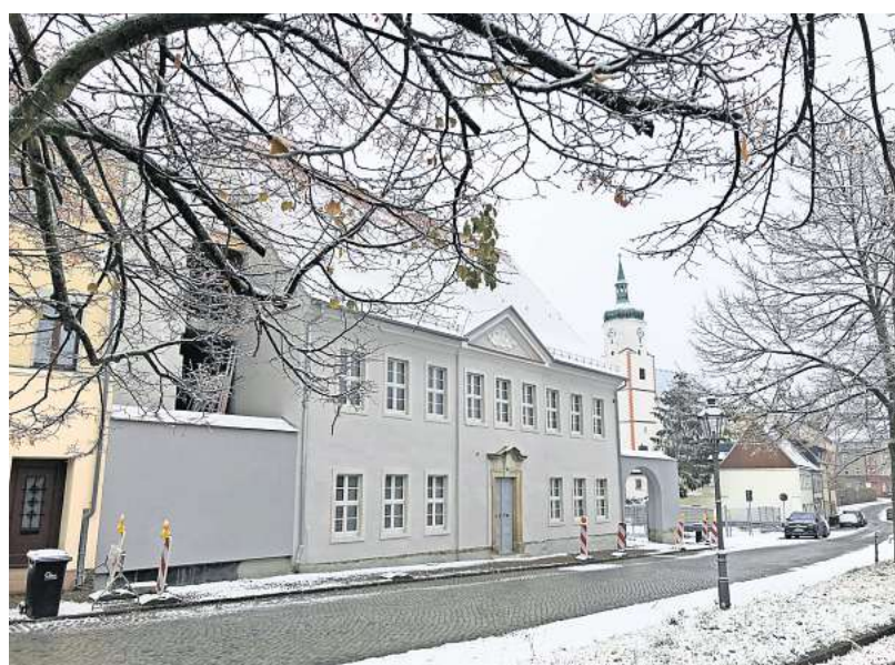
Im Frühjahr 2023 ist es soweit: Dann soll das barocke Ringelnatz-Geburtshaus im Crostigall nach umfangreicher Sanierung als sächsisches Literaturhaus eröffnet werden.
