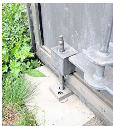
Der Bolzen zum Feststellen des Tores ist inzwischen gewechselt worden.
